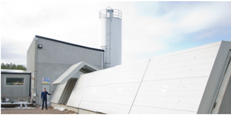
Grusmagasinen framför den nya betongblandarstationen.
