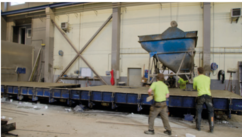
Att gjuta betongelement är ett tungt handarbete.
